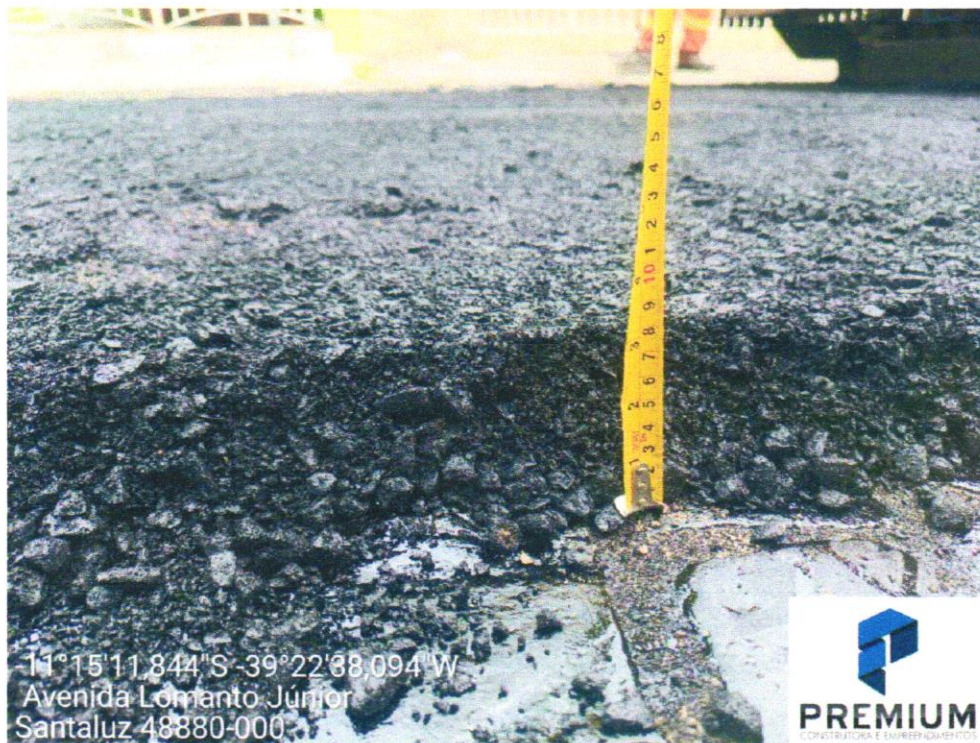
Foto 04- Espessura da massa asfáltica.
