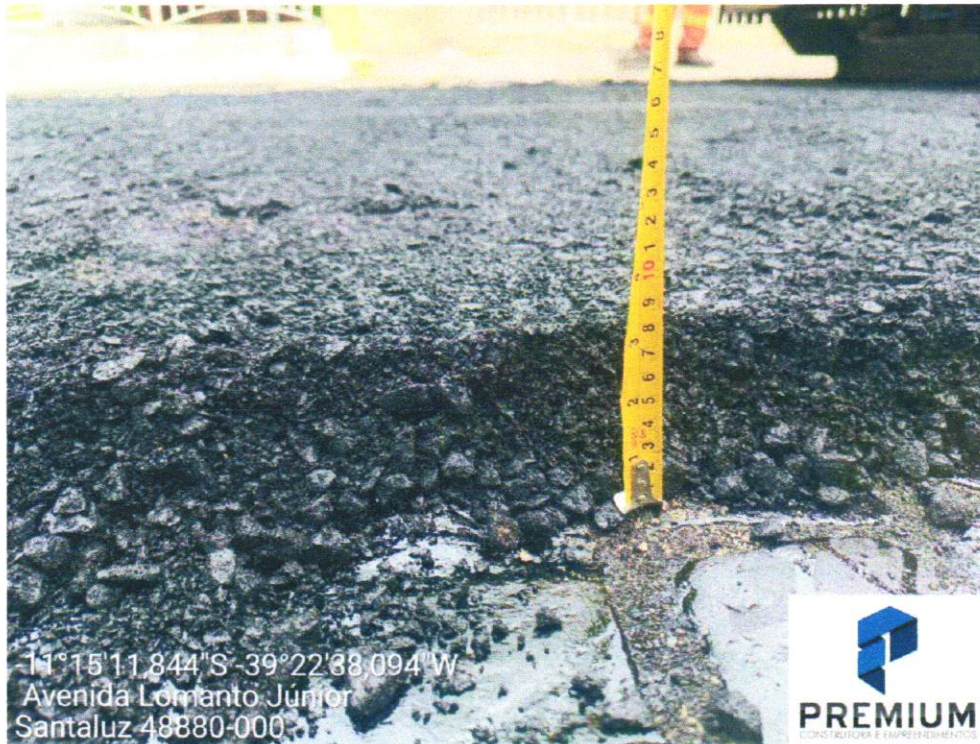
Foto 03- Espessura da massa asfáltica.
