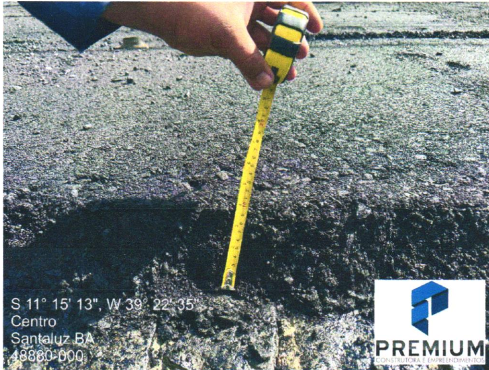
Foto 01- Espessura da massa asfáltica.
